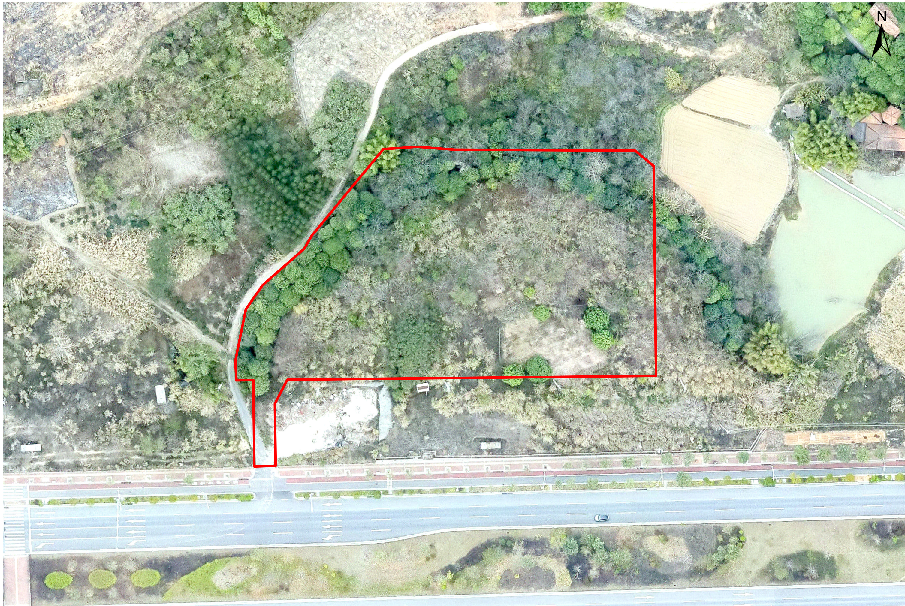
220kV君武（桥头）变电站工程项目
