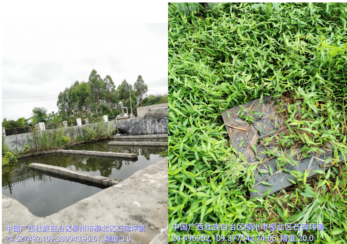
图 3.4-5 石碑坪镇大仙村农村生活污水处理设施
