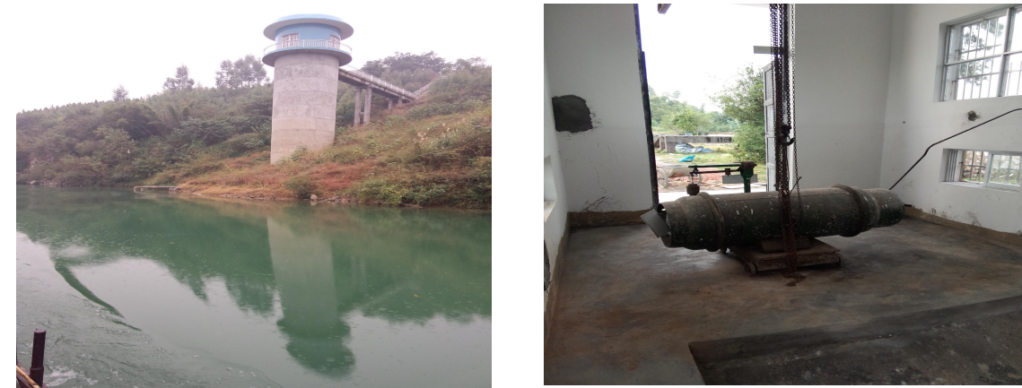
图 2.4-2 石碑坪镇新维水源地取水口
