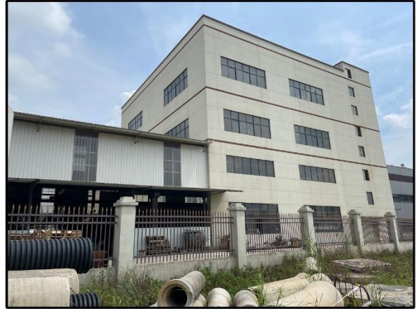
项目东面30m处的广西 贺尔德实业有限公司
