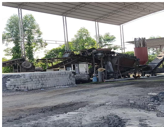
项目现有破碎、球磨车间现状
