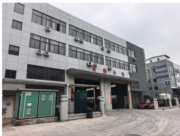
项目东面现状
