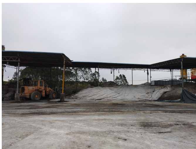
项目铁粉、炉渣加工区
