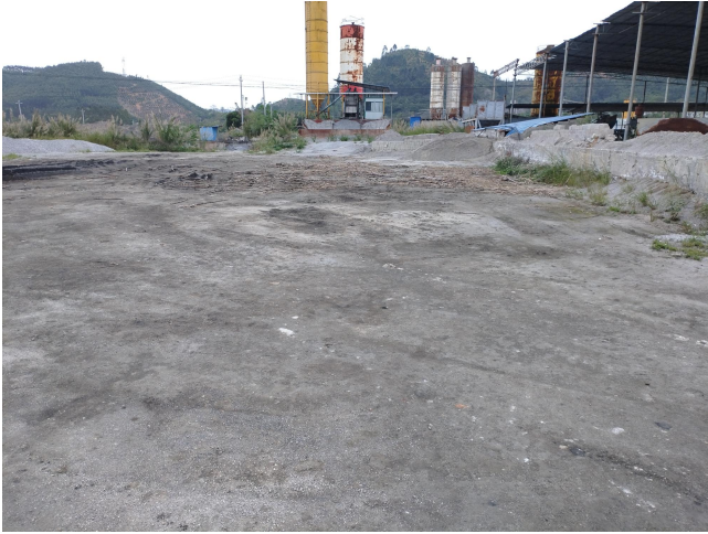
项目原材料堆放区
