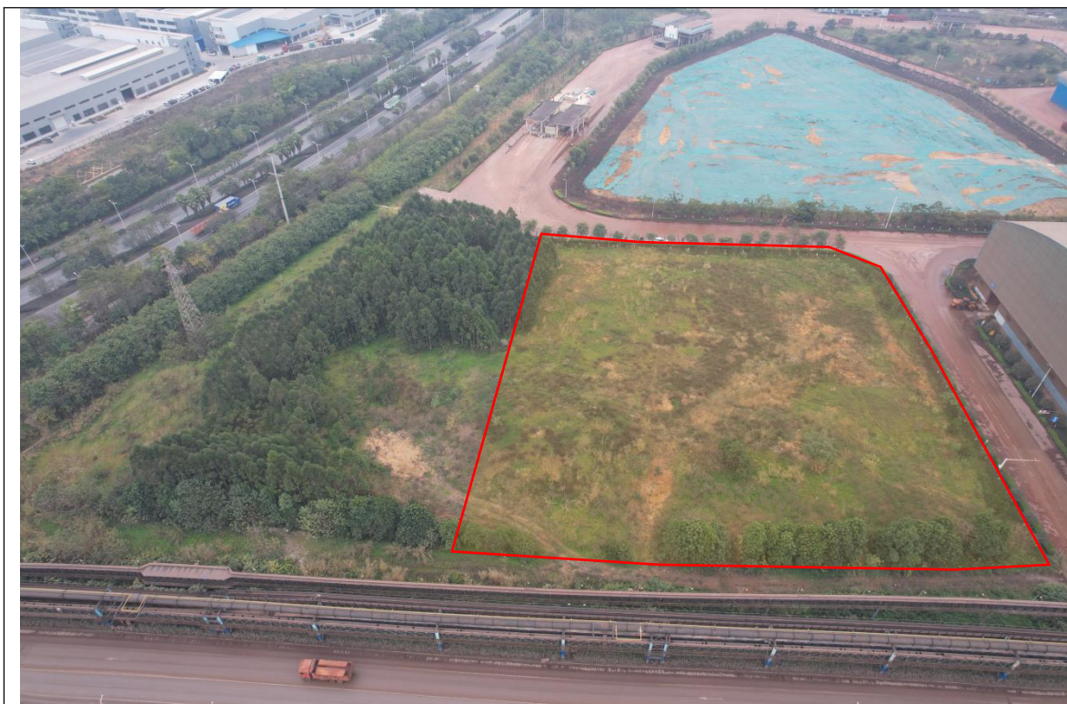
柳州钢铁股份有限公司新建选址项目红线范围现状
