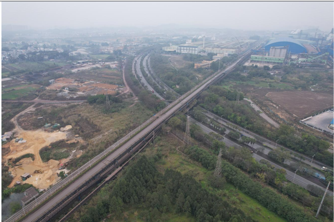
柳州钢铁股份有限公司新建粗苯储销选址项目东侧现状
