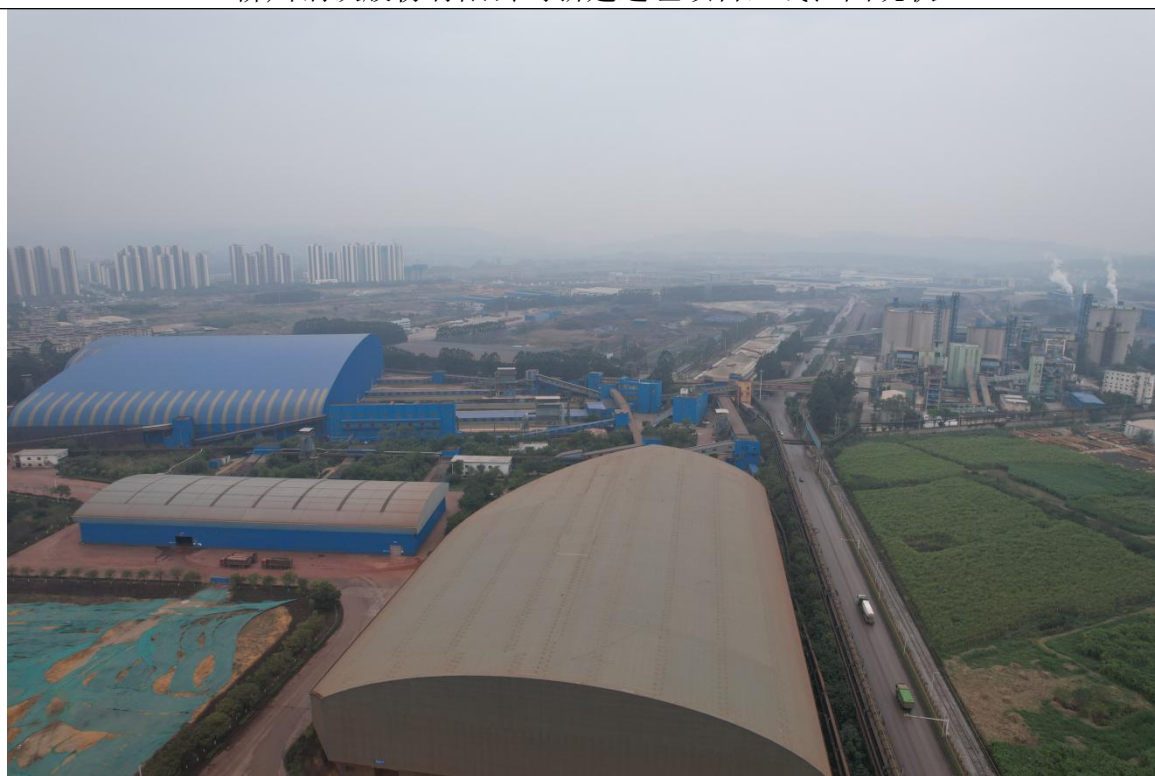
柳州钢铁股份有限公司新建粗苯储销选址项目西侧现状
