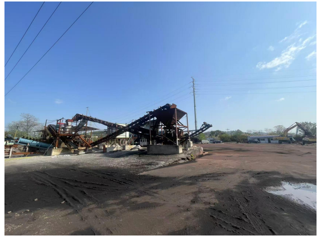
项目机制砂生产区
