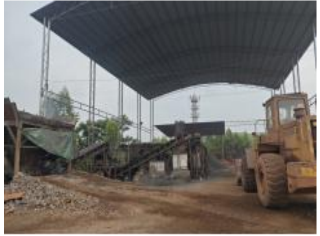
项目破碎厂棚
