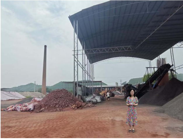
工程师现场踏勘情况
