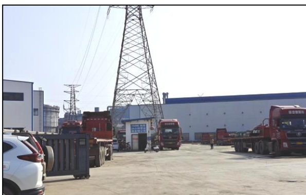
项目东面现状
