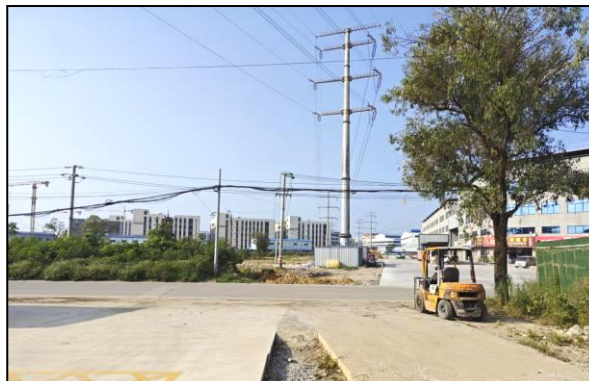
项目南面现状
