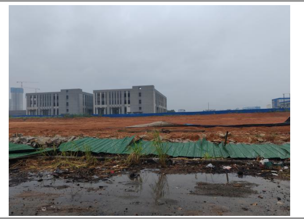
项目北面现状
