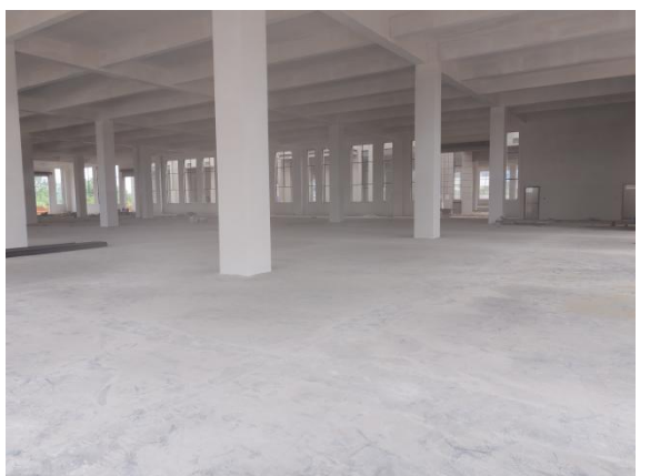
项目厂房现状
