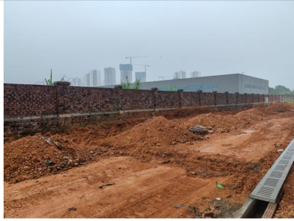
项目东面现状
