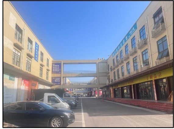
项目东面为商铺
