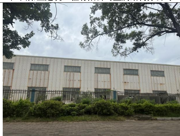
项目南面柳州众菱汽车集团有限公司厂房
