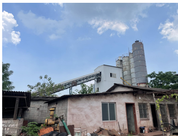
项目西北面混凝土厂
