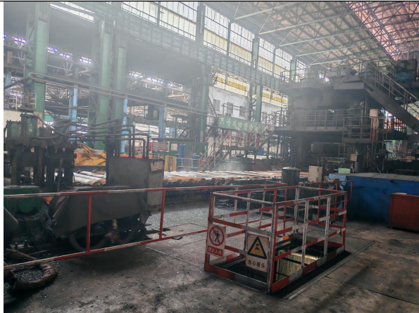
中板线除鳞、轧机现状
