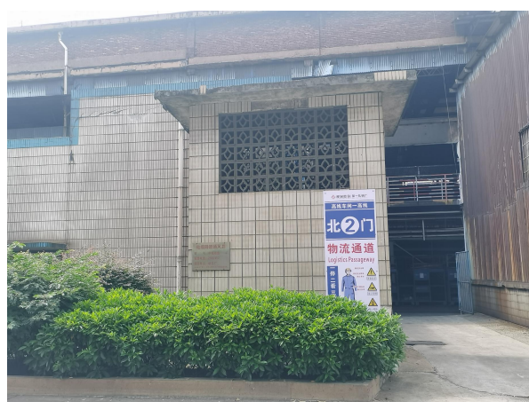
一轧厂中板线南面——高线车间
