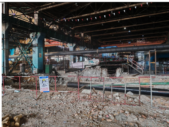
2023 年 3#炉技改工程，目前 3#炉已拆除
