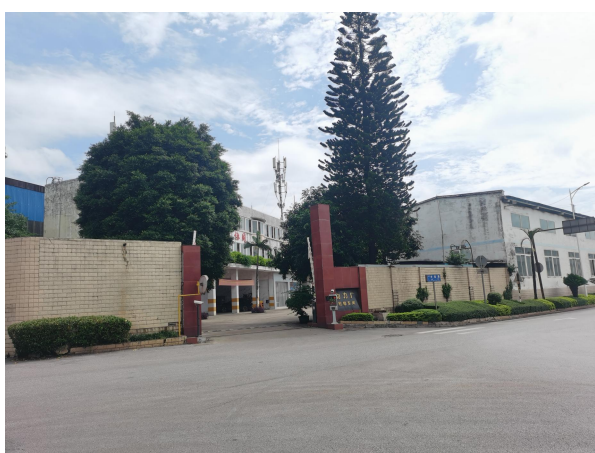
一轧厂中板线东南面——动力厂检修车间
