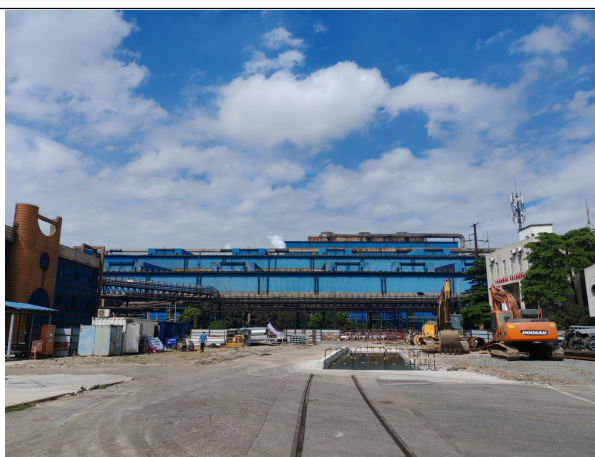
一轧厂中板线西面——120t 转炉车间
