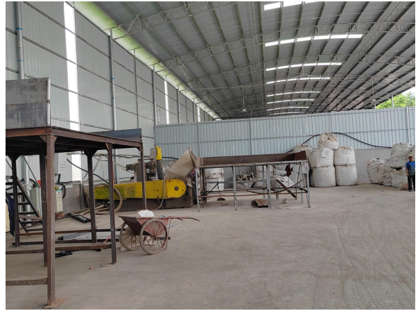
拟建项目场地现状、原料堆放区
