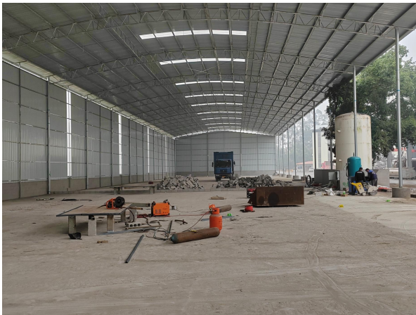
项目厂房北面空置厂房
