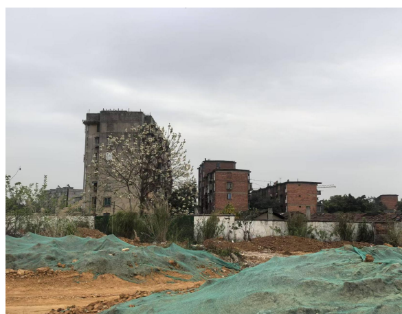
项目东北面 60m 建三生活区
