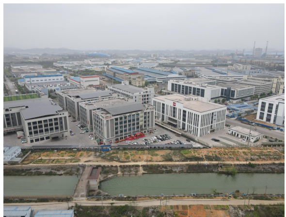
项目西面园区排水干渠
