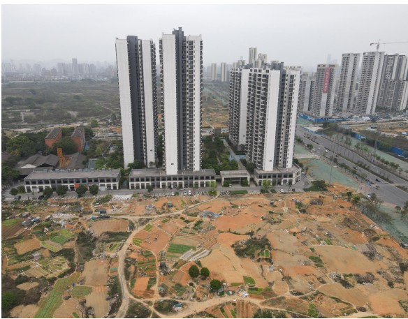
项目东面空地、白露锦苑
