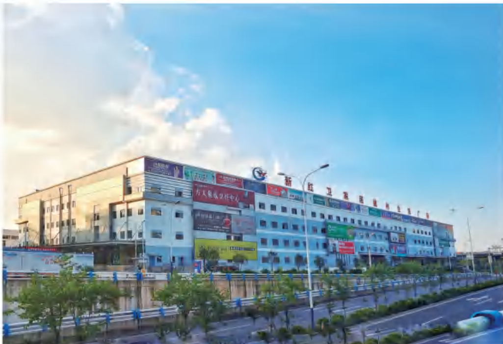
新红卫家居建材生活广场实景
